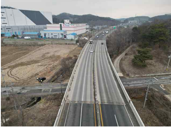
교량 상부 전경
