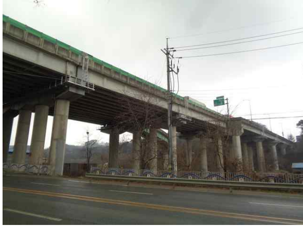
교량 측면 전경
