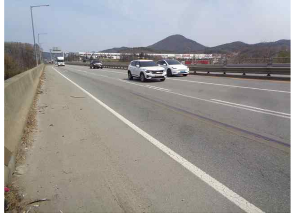
교량 상부 전경
