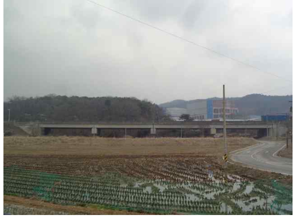
교량 측면 전경
