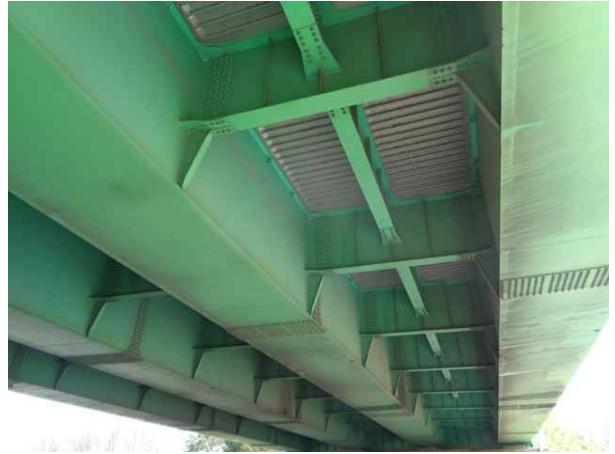
바닥판, 거더외부 전경
